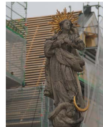
Aufwendige Reparaturen waren am Dachstuhl der Bruderschaftskapelle nötig
