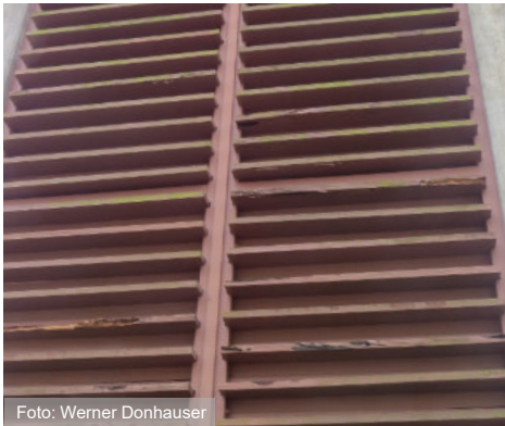
Die schadhafte Schalljalousien am Glockenturm
