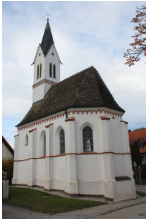
Die Schäden an St. Leonhard sind behoben
