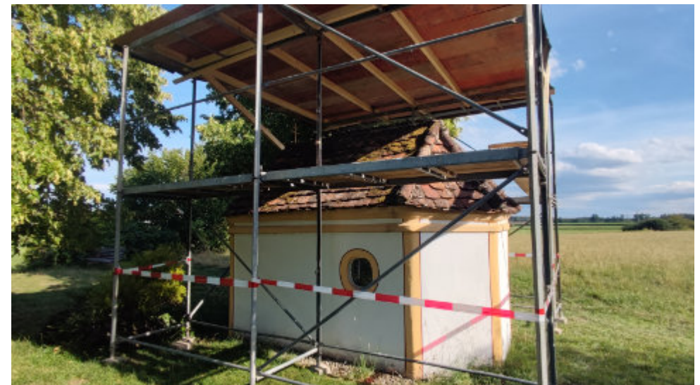
Nicht nur das Dach, auch die Fassade der Kapelle musste saniert werden
