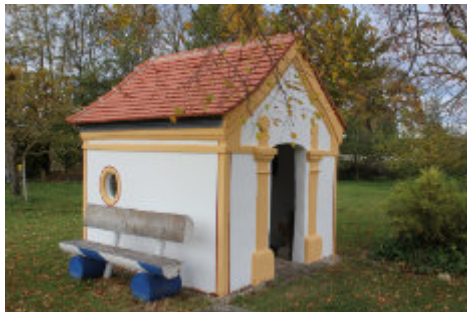
Die Loosbach-Kapelle in saniertem Zustand
