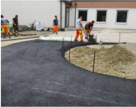
Der Parkplatz erhält eine Asphaltdecke
