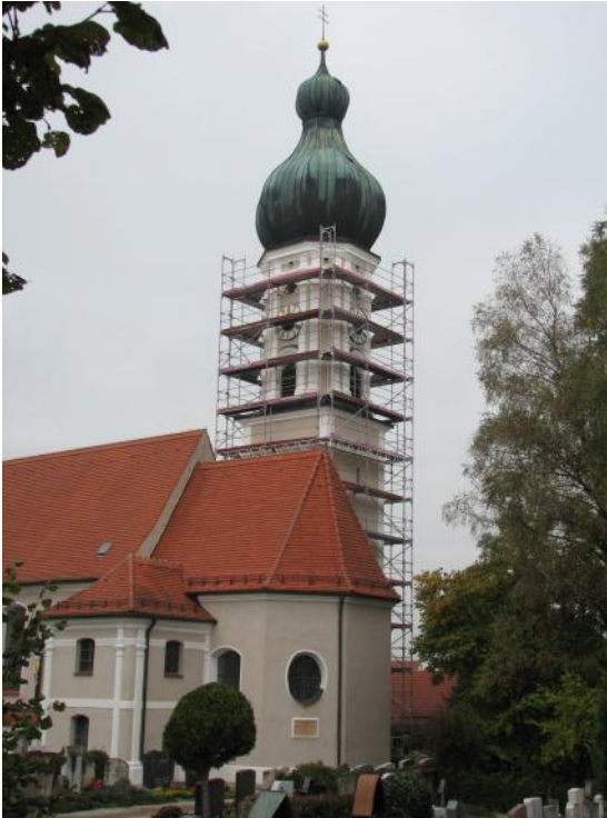
Nachbesserung: Abgeblätterte Farbe musste ersetzt werden.
